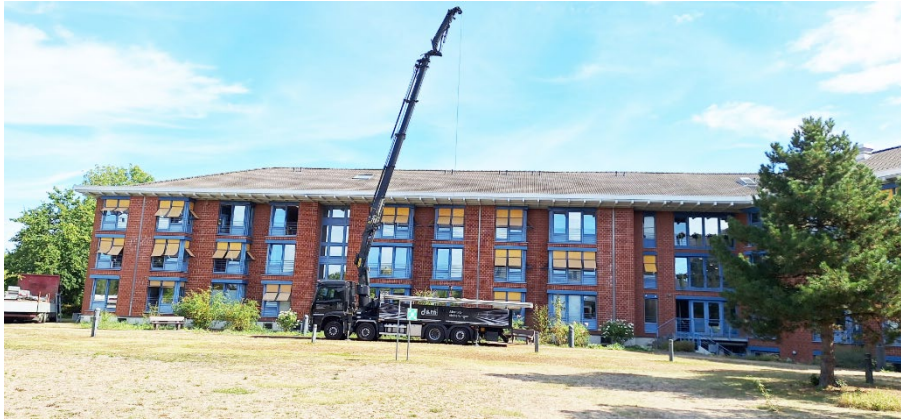
Die Absturzsicherungen haben bei der Montage der Paneelen dafür gesorgt, dass zu keinem Zeitpunkt Gefahr für die Baukolonne, für Mitarbeitende oder Bewohner bestanden hat. Foto: Caritas · Axel Küppers
