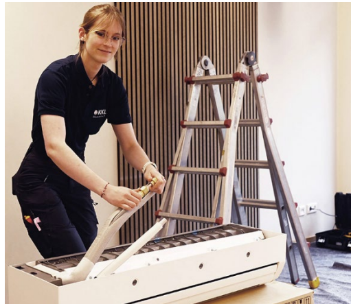
KKL-Auszubildende Hanna Walczuch bei der Montag der Split-Klimaanlagen im Speisesaal des St. Theresienheims. Die 21-Jährige befindet sich im ersten Lehrjahr als Mechatronikerin für Kältetechnik. Ihr Einsatz bei der Caritas ist ein Projekt im Zuge der Ausbildung.
