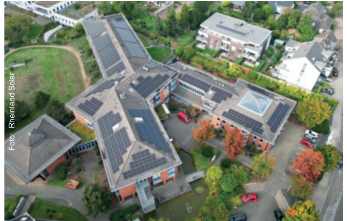
Rund 2.600 Quadratmeter Dachfläche wurden am Caritas-Standort Montanusstraße in Grevenbroich mit Photovoltaik-Modulen belegt.
