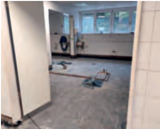
Sämtliche Leitungen wurden im Rahmen der Sanierung neu verlegt.
